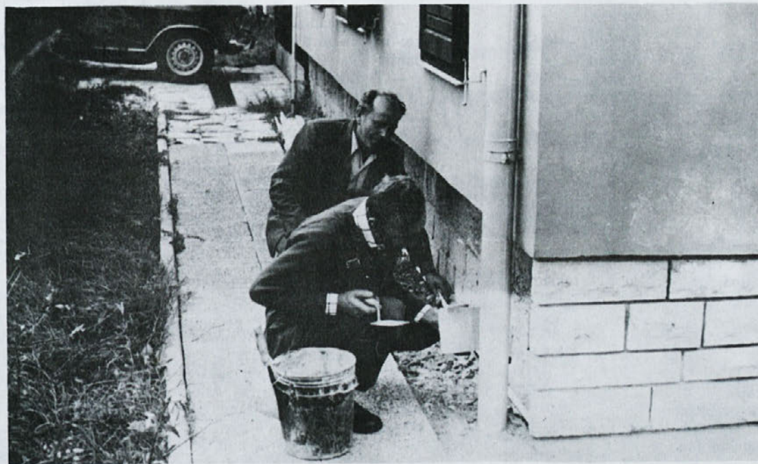
V lastni režiji smo v domu v Savudriji napravili cel niz vzdrževalnih del. Delavca Rudi Retelj in Tone Hrovat sta opravila vsa vzdrževalna zidarska dela na zgradbi. (Foto: arhiv Laboda)
