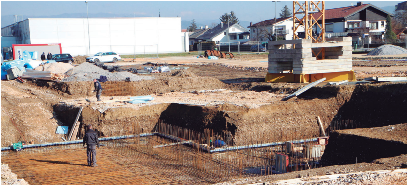
Dela za gradnjo oskrbovanih stanovanj so v teku.
