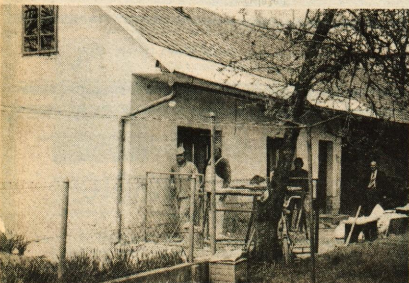
Tudi urejanje in obnavljanje pročelij na zasebnih zgradbah je del akcije Snažno-lepo-zdravo
