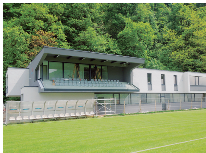
Večfunkcionalni športni objekt Skalna klet 2019
