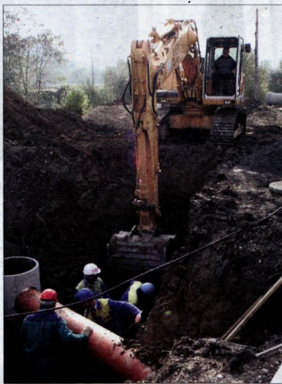
Gradnja primarnega omrežja pri Pocačevem mlinu na Tebarju
