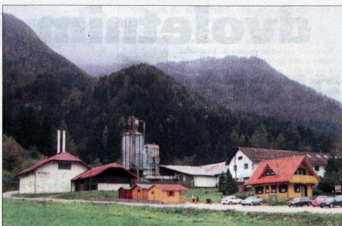
Sistem ogrevanja v Gornjem Gradu je bil idealno zamišljen: levo zgradba Engoa s kotlovnici in vsem potrebnim za ogrevanje. Desno stoji podjetje Smreka, ki naj bi bilo dobavitelj lesnih odpadkov.
