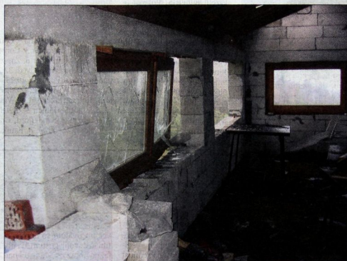
Zidaki so poleteli nekaj metrov čez cesto ...
