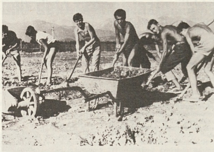
Graditelji športnega stadiona v Kranju, 1961. leta.
