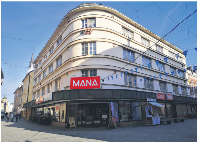
Najbolj znana blagovnica na križišču Prešernove in Stanetove ulice je dolgo časa sodila med zgradbe, ki s svojo zunanostjo kazijo podobo mestnega središča v Celju. (Foto: arhiv NT/SHERPA)
