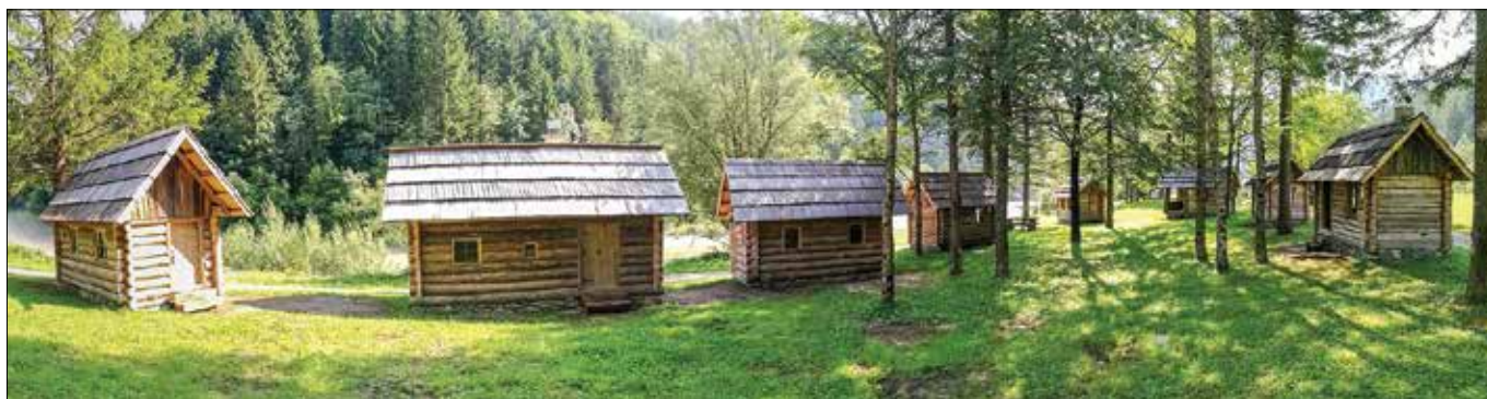
Na novo razmeščene etno hišice v Lučah so dobile temelje iz naravnega kamna. (Fotodokumentacija Občine Luče)
