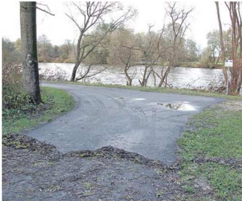
Dovozna pot do gradbišča platoja in kasneje do čistilne naprave in upravne stavbe komunale bo speljana po poti pri trgovini Roto na Meleh.
