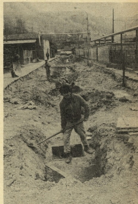
Cesto do Rudnika Trbovlje rekonstruirajo. Urediti je bilo treba kanalizacijo ter utrditi spodnji ustroj cestišča. Dela izvaja SGD Beton — tozd Operativa Zasavje, Trbovlje. (foto: A. Bregant)
