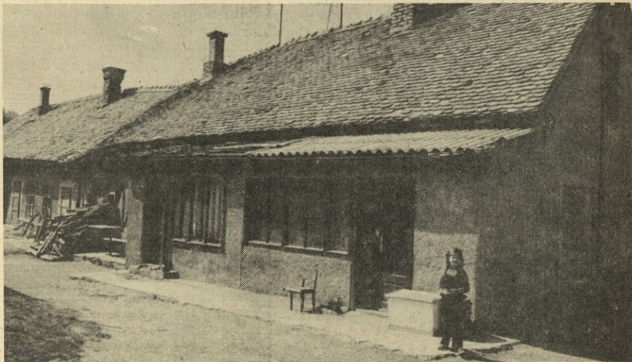
Stanovanjska hiša v stari rudarski koloniji Žabjek v Trbovljah. V zadnjem delu stavbe so bili stanovalci preseljeni zaradi ogroženosti po posedanju dela zgradbe. (foto: B. Klančar)
