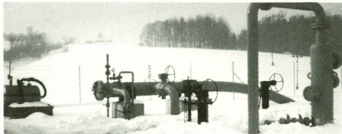
Na sprejemno-čistilnih postajah pride iz cevi poseben čistilec, s katerim občasno čistimo plinovode
