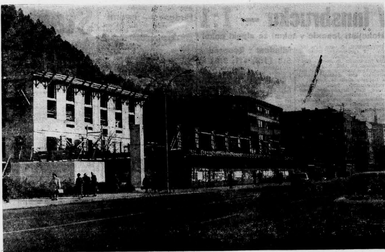
NOVO NA JESENICAH — Nasproti kolodvoru so začeli tu graditi stavbo, v kateri bodo razen stanovanj tudi trgovski lokali. Investitor stanovanjskega dela stavbe je GP Sava, ki gradi za trg, medtem ko trgovski del investira več trgovskih podjetij iz Radovljice, Lesc, Bleda, Škofje Loke in Jesenice. Načrte za novo jesniško poslopje je izdelal inž. D. Sevnik, atelje za arhitekturo iz Ljubljane, gradi GP Sava Jesenice.
