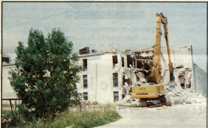
Pogled na rušenje nekdanje predilnice. Na tem mestu bo zrasla nova proizvodnja hala; sedanja namreč ne ustreza namenu načrtovane proizvodnje.
