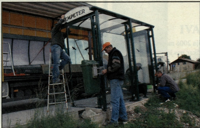
Pri montaži avtobusnega postajališča v Sempetru
