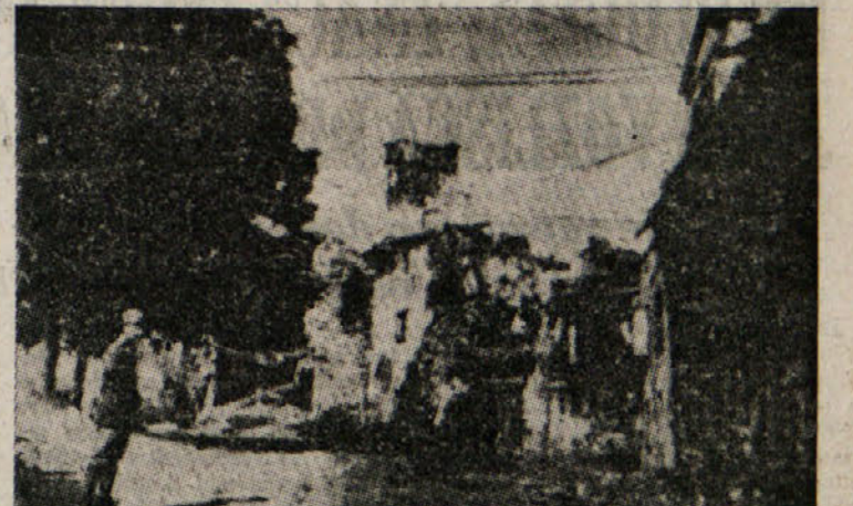
ŠTEVERJAN: hudo poškodovano poslopje cerkve v Števerjanu. Slika je bila napravljena v maju 1916.
