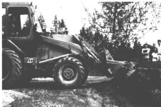
Zadnja dela na cesti
