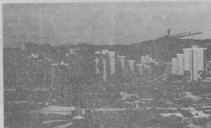
Pogled na gradbišče Imosa v juliju 1982.
