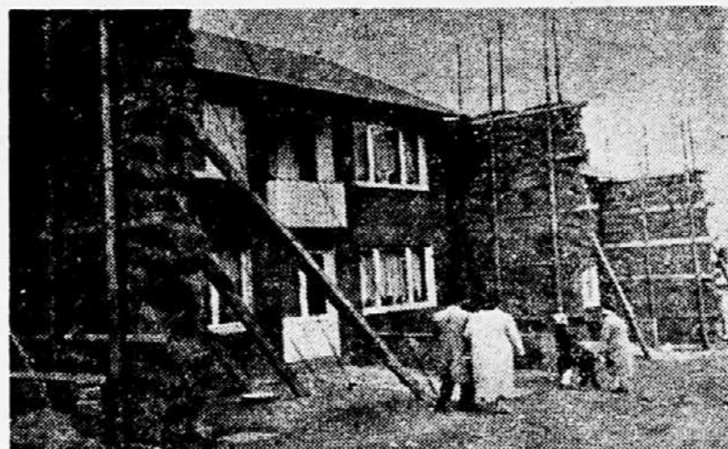
V helgolandskem pristanišču čistijo morsko dno vojnih ostankov. Med zadnje vojne so v tem pristanišču potopili velikanske količine bomb, min in drugega razstreliva. Da bi pri teh delih ne poškodovali hiš, so jih obdali s slamnatimi ščitniki.
