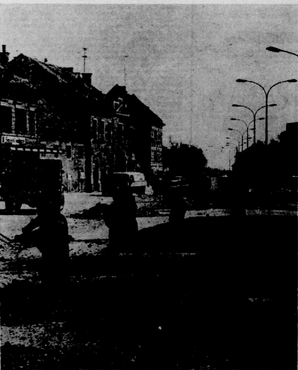
NA CESTI CELJE-LJUBLJANA so te dni začeli s spomladanskim krpanjem ob sime poškodovanega vozlišča. Na sliki delo na cesti v Zalci.
