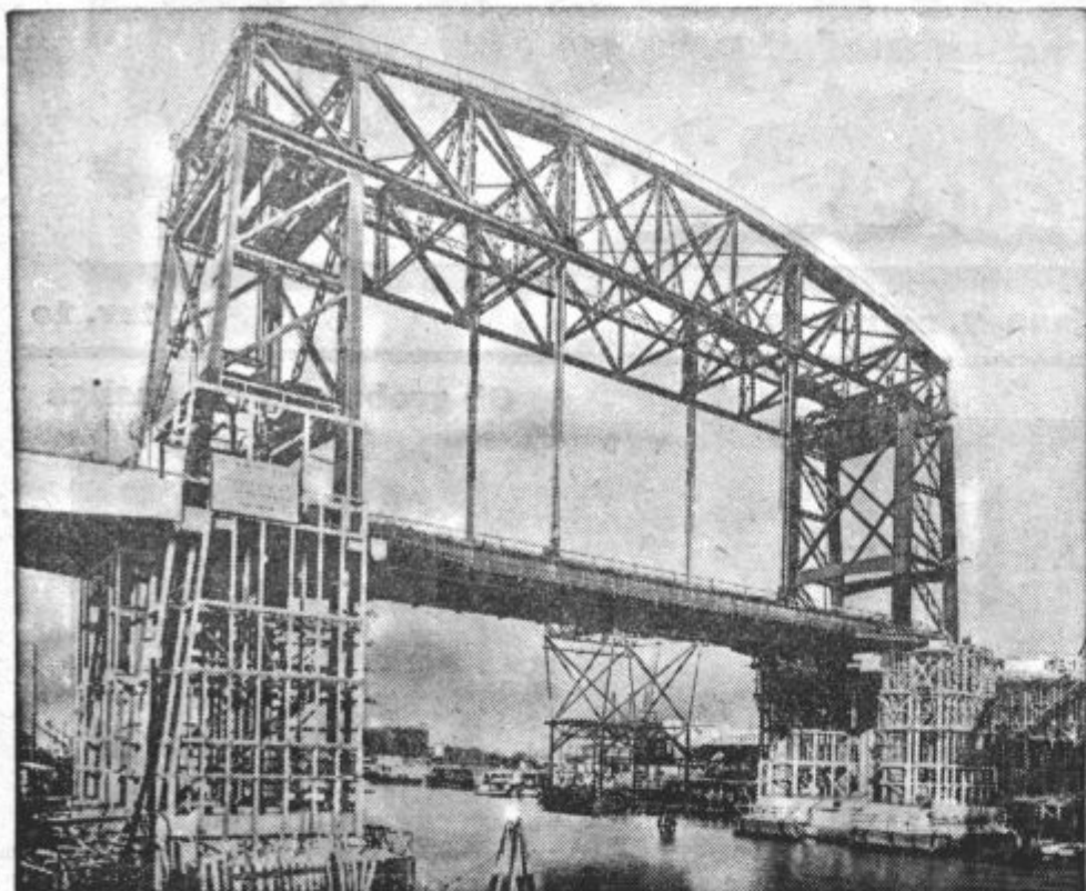
NOV MOST V ARGENTINI. V Buenos Airesu so zgradili Nemci dvigalni most čez Riachuelo. Most ima v prvem nadstropju višino 24 m, lahko pa ga odpro do višine 45 m, nakar grede skozi tudi največje ladje
