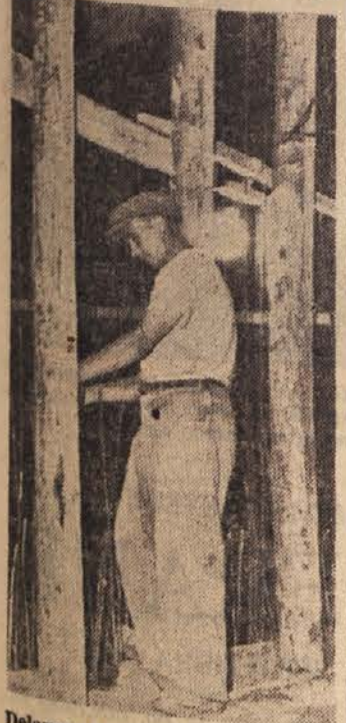
Delavec veže armature za betonske cisterne v vinski kleti v Dobrovi, ki bo popolnoma dograjena do prihodnje jeseni, zdaj pa je urejen zorliti obrat
