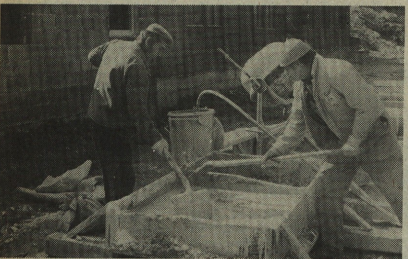
Nedeljko Kukić in Vinko Hrženjak mešata malto za ometavanje sanitarij v naselju
