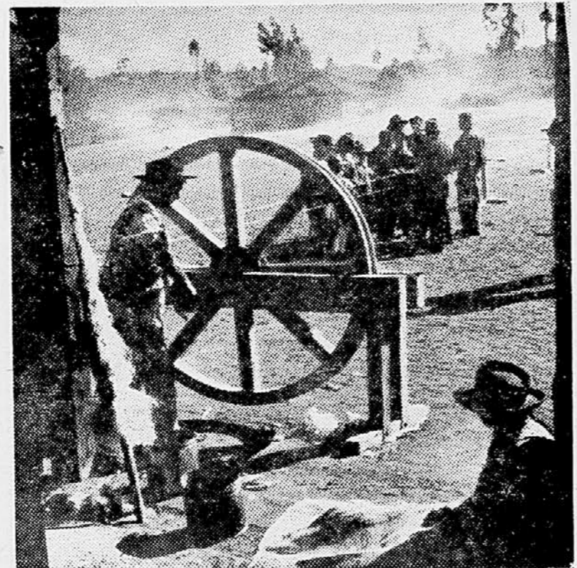
V San Gerardu v Ekvadorju so morali do nedavna prestri prejo na roko, kar je šlo zelo počasi. Eno balo so predli ves dan. S preprostimi strojem, ki ga vidimo na sliki, je delo opravljeno v eni uri.
