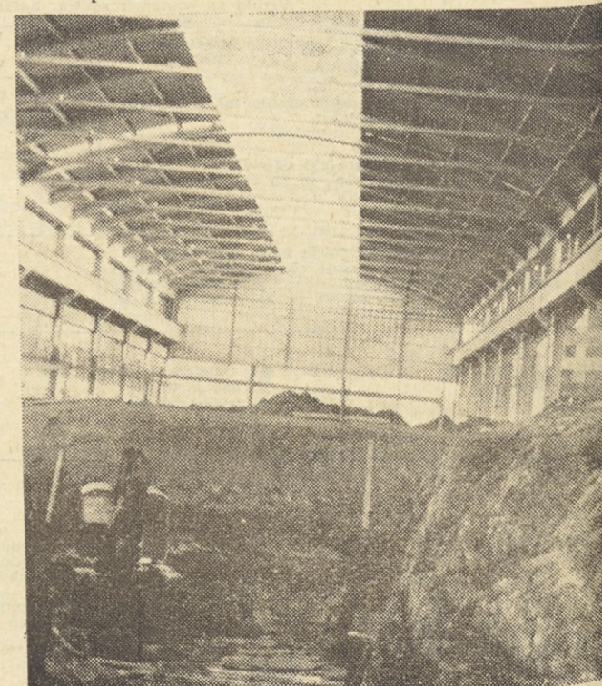
Na gradbišču v »Impolu« v Slovenski Bistrici kopljejo gradbeno jamo za temelje strojev. Čeprav je delo pod streho, je vode in blata kar preveč
