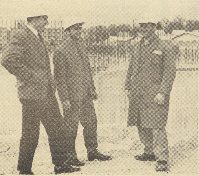
Vodstvo gradbišča v Ptuju. Od leve proti desni stoje: Oto Roškar, Jakob Gajšt in Vinko Vajt
