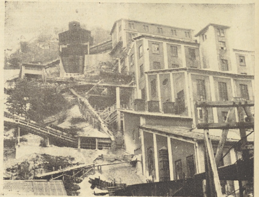
Vsi temelji novega objekta v rudniku Mežica so vklesani v živo skalo
