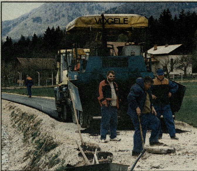
Pri asfaltiranju v Rakovljah
