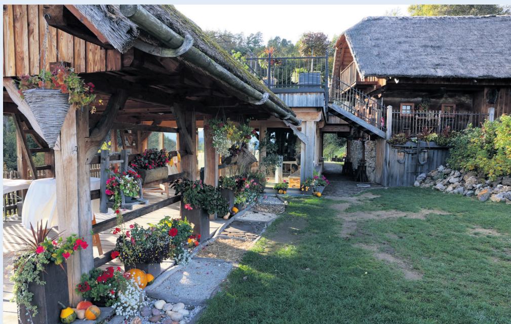
Dvesto let stara lesena hiška s slamnato streho je posebnost kmetije (desno). V njej je tako, kot je bilo nekoč.
