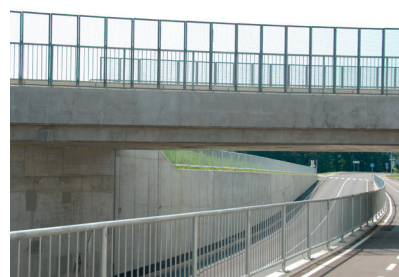
Zgrajenih bo 19 novih izvennivojskih prehodov. (Na sliki izvennivojski prehod na cesti Ljutomer–Ormož)
