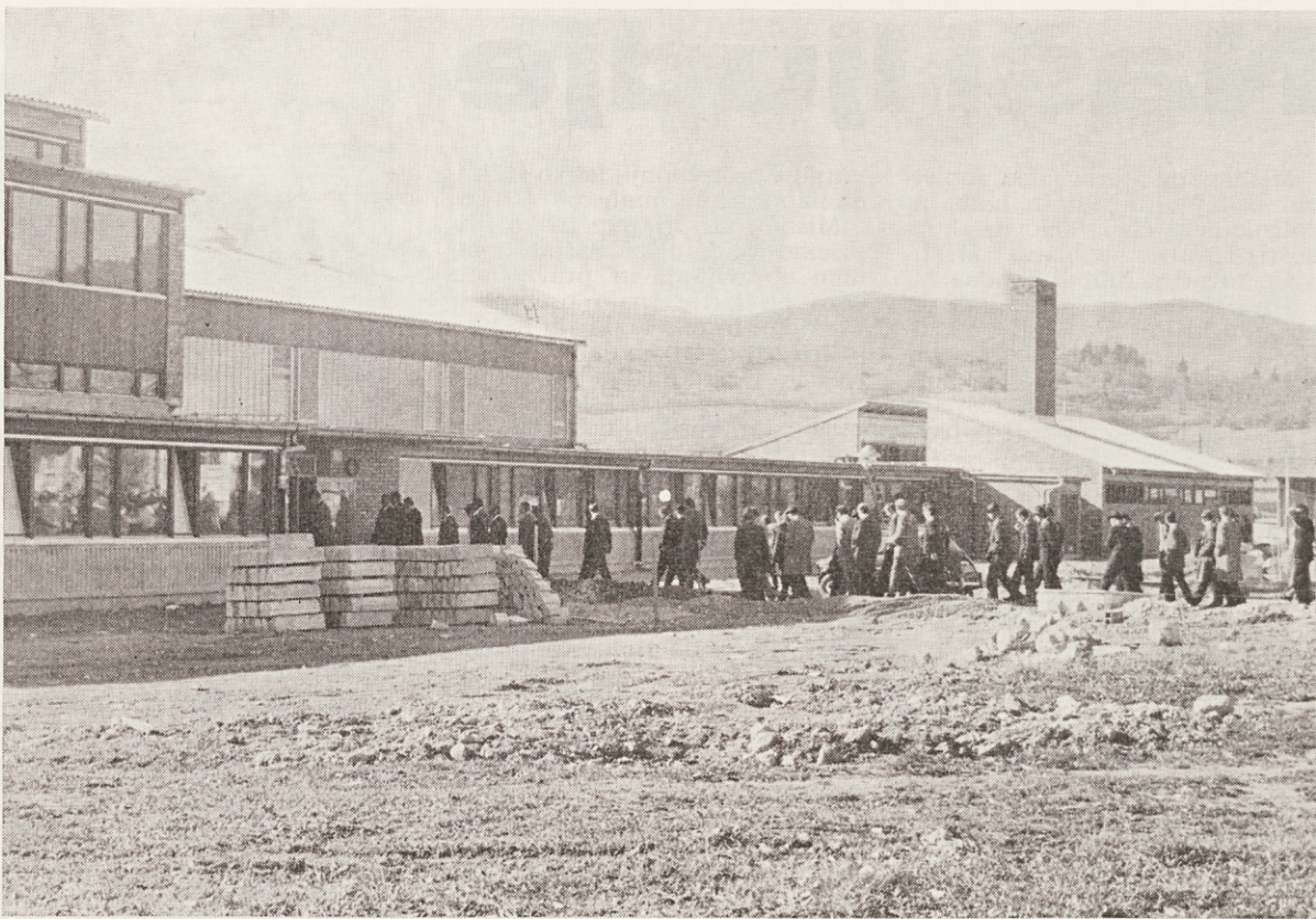
Nova šola v Starem trgu bo zadostila željam prebivalcev in njihovih otrok. Gradbena dela so končana, čakajo le še na notranjo opremo
