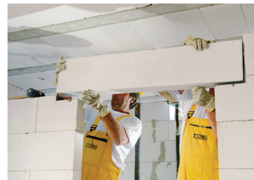
Ytong nenosilne preklade za premostitev odprt in nosilnih stenah.
