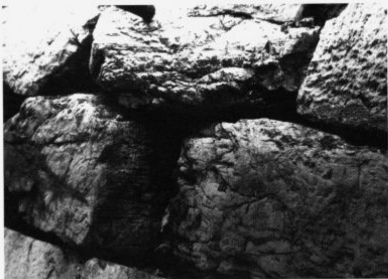
Fugiranje je bilo med kamnitimi bloki izvedeno po posebni recepturi dipl. ing. gradb. Alberta Plemlja, julij 1991
