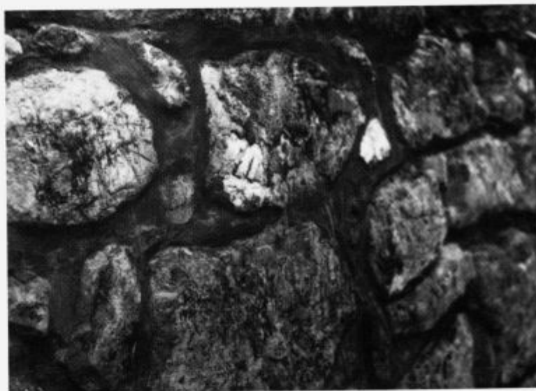
Fugiranje je bilo med kamnitimi bloki izvedeno po posebni recepturi dipl. ing. gradb. Alberta Plemlja, julij 1991
