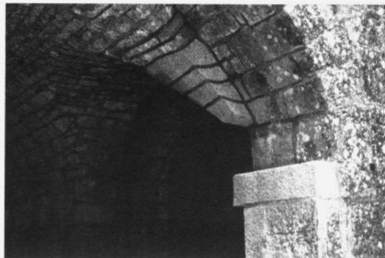
Obnovljeni detajl v pretočnem kanalu
