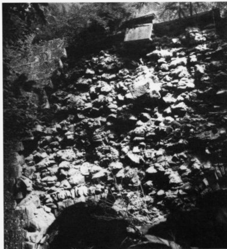
Zadnja stena Kanomeljskih klavž je danes že v celoti porušena (Foto: Jurij Bavdaž, 1972)
