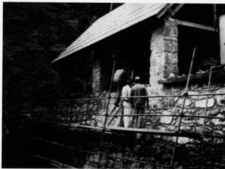
Strokovni nadzor pri obnovi Belčnih klavž, september 1990 (Foto: Samo Bevk)
