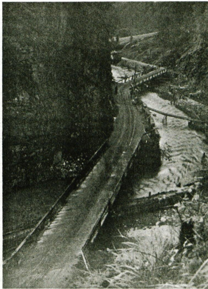
Gorenjska družinska podjetja so zmogla in tudi danes zmorejo veliko. Podjetje Slavec je, na primer, gradilo tudi ceste in mostove v dolini Kokre.
