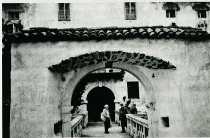
Obnovljen Lantierijev most, ki spada med najlepše v Evropi, foto: Martin Silvester
