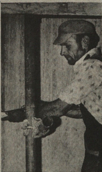
Suljo Žalić popravlja še zadnje »lepotne napake« v jasku dvigala v stavbi radiološke postaje v jedrski elektrarni Krško.
