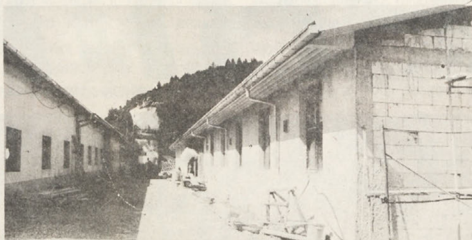
Novi proizvodni prostori za konfekcijsko dejavnost. Danes sicer še gradbišče, kljub temu pa znotraj že teče proizvodnja – izdelava blazin za prikolice. Kmalu urejeni prepotrebni delovni prostori.
