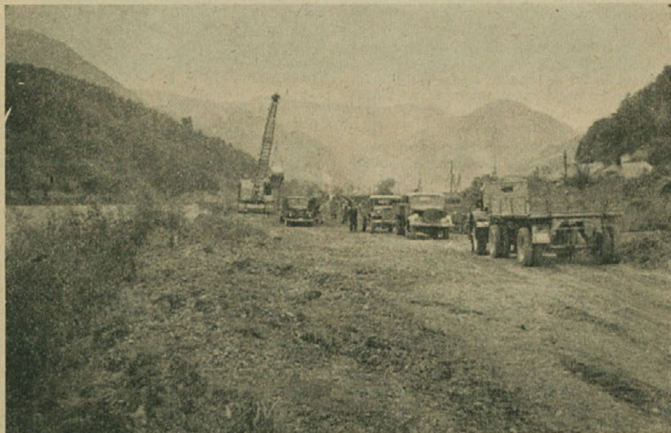
Mehanizacija je ponos podjetja; izkop in odvoz materiala pri regulaciji Savinje
