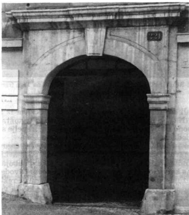
Sl. 1 Portal Strassoldove hiše iz škofjeloškega konglomerata na Novem trgu št. 6 v Ljubljani. Foto A. Ramovš.
