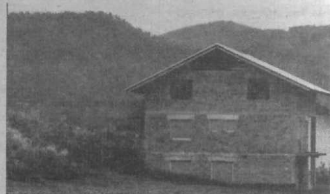
Ob novozgrajeni hiši se lepo vidi, koliko materiala je hudournik v nekaj sto letih nanese. Voda je doslej tekla po vrhu tega grebena, zato ni nič čudnega, da se je večkrat razlila in poplavlila bližnja polja, zdaj pa skrbi zaradi poplav ne bo več.
