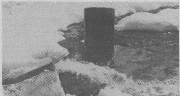
Črni preizkus prve vrtnice. Črpamo 15 l vode na sekundo
