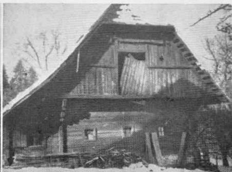
Sl. 6. Zavarovana dimnična hiša (s konca) v Št. Janžu pri Vuženici
