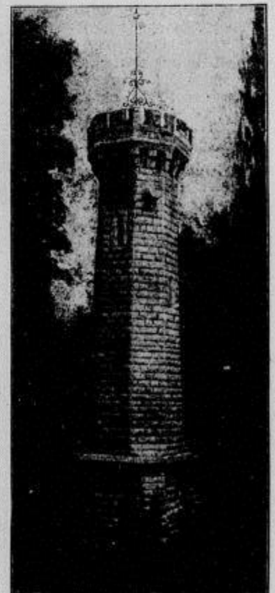
Luftschacht über dem Tunnel bei Ueberlingen. (Mit Text in voriger Nummer.)
