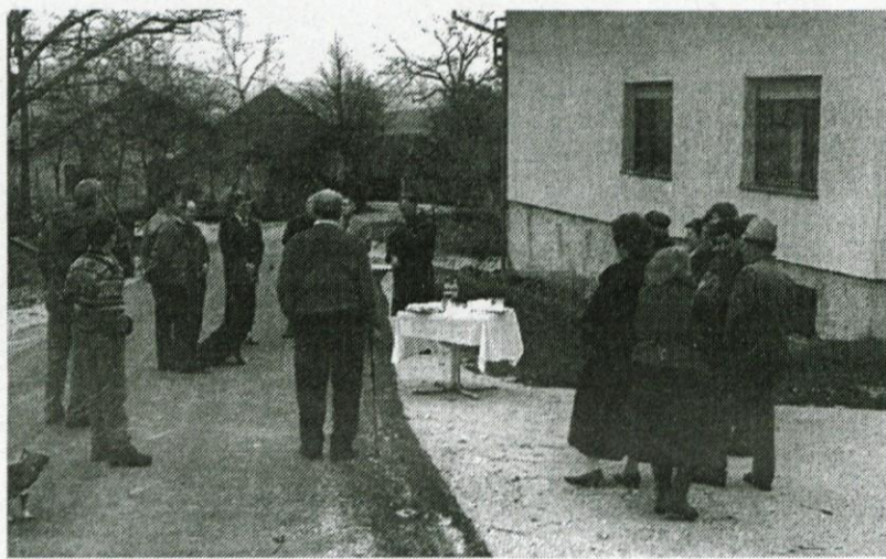
Otvoritev nove ceste, ki je veljala skoraj 22 milijonov tolarjev, je bila v vasi Sela. Pogostitev gostov in za izgradnjo najzaslužnejših pa so pripravili na turistični kmetiji Habjan, na Vrhu pri Višnji Gori.
