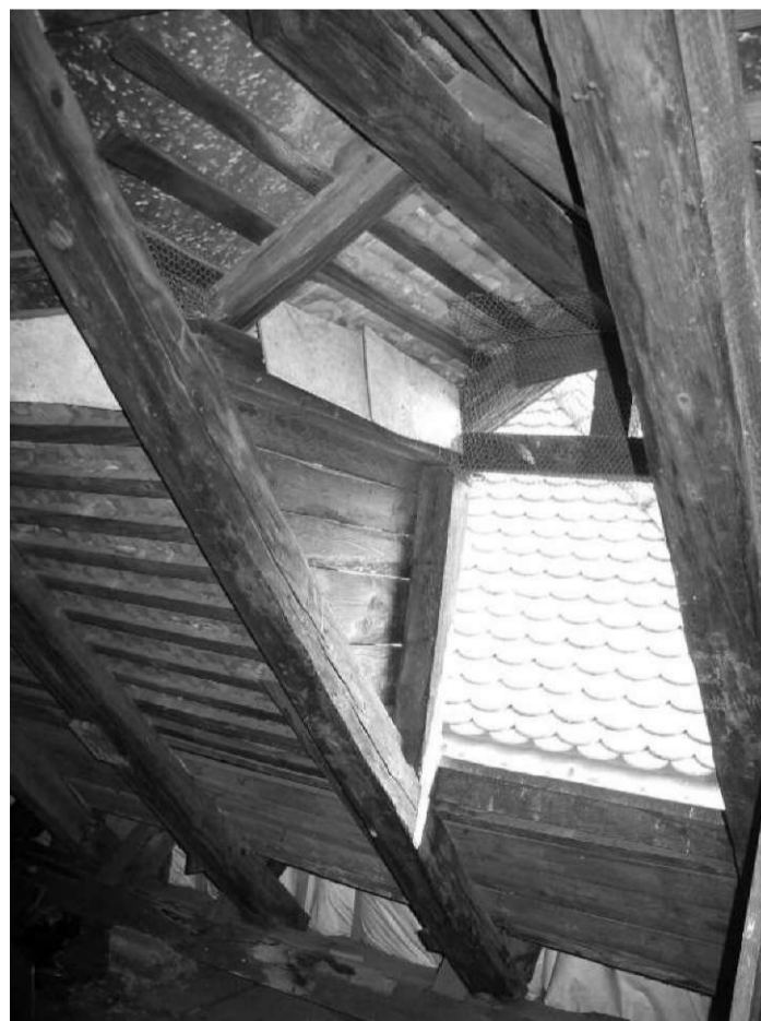
Slika 30: Nastrešnica na vzhodni strešini
