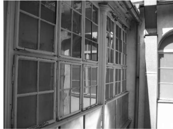
Slika 4: Zahodna stena svetlobnika
