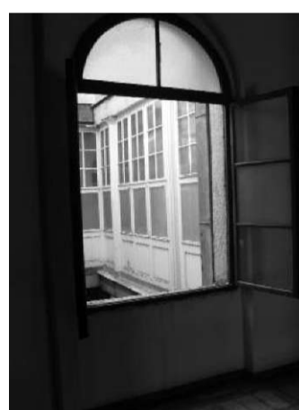
Slika 22: Pogled skozi okno na hodniku v svetlobnik
