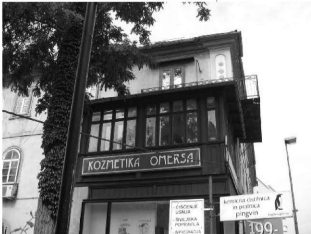
Slika 15: Lesena veranda na vzhodnem pročelju
