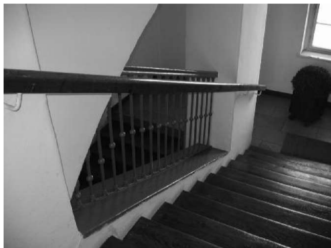
Slika 19: Kovinska ograja na stopnišču v severnem delu stavbe
