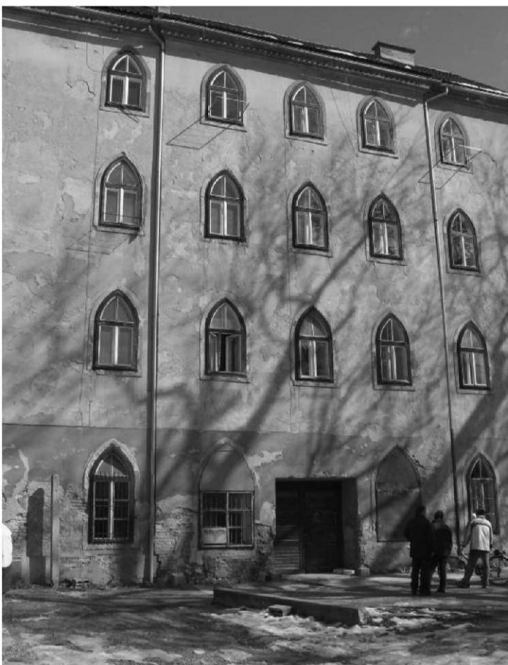
Slika 9: Vzhodno pročelje s šilastimi okni
