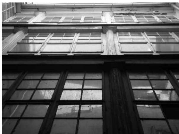
Slika 9: Pogled po svetlobniku od spodaj navzgor
