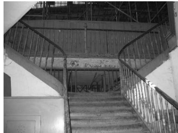
Slika 10: Triramno stopnišče v severnem delu stavbe
