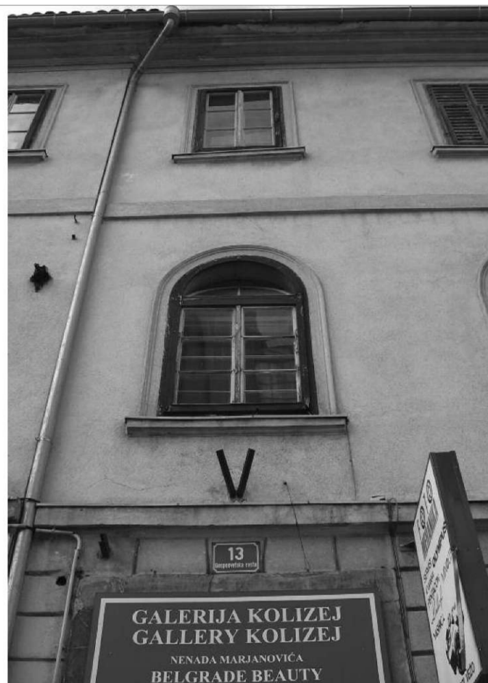
Slika 4: Osrednja os severnega pročelja
