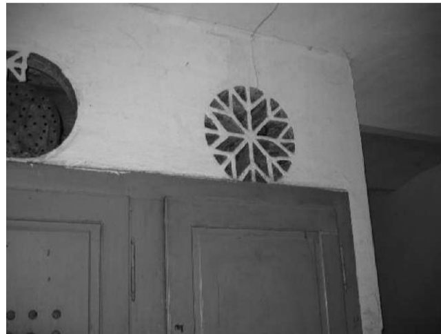
Slika 26: Opečnata prezračevalna lina v obliki osmerokrake zvezde v vzhodni steni nad shrambami
