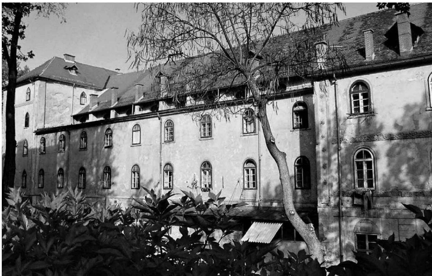
Slika 6: Vzhodno pročelje - pogled z Župančičeve ulice
