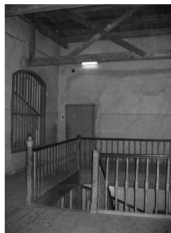
Slika 28: Leseni podestv južnem delu stavbe z odprtino v steni stopnišča
