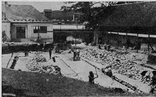
Kopanje temeljev za novo upravno poslopje
