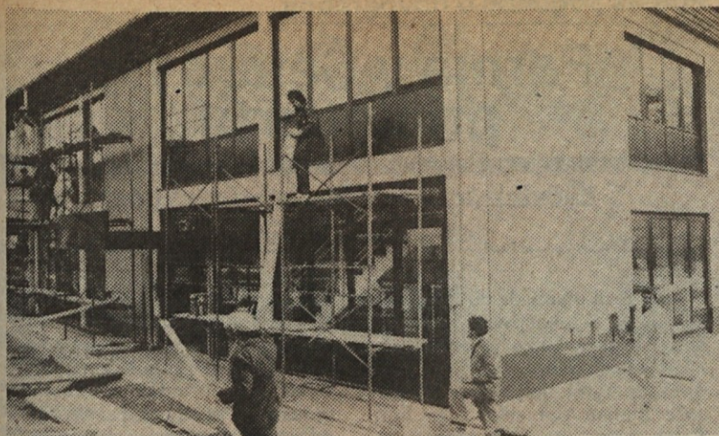
Delavci pri zaključnih delih na objektu LB v Ravnah
