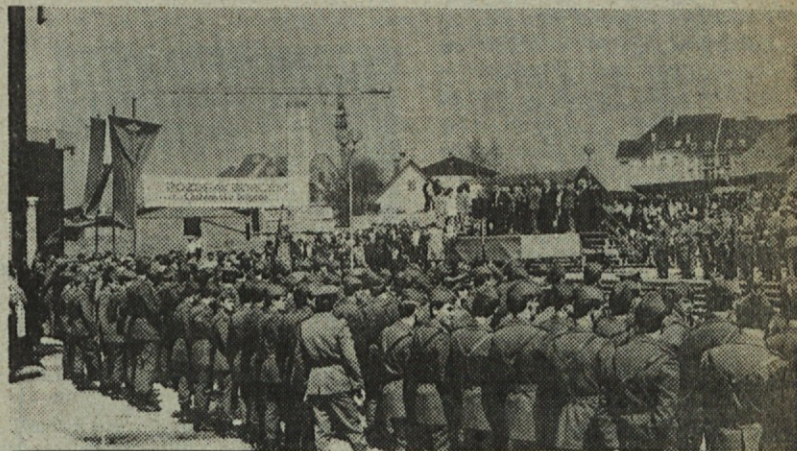
Sprejem štafete v Ptuj. V ozadju gradbišče našega tozda GE Gradije
