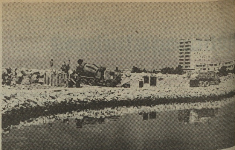
Betoniranje zidu v lukobranu za marino v Umagu
