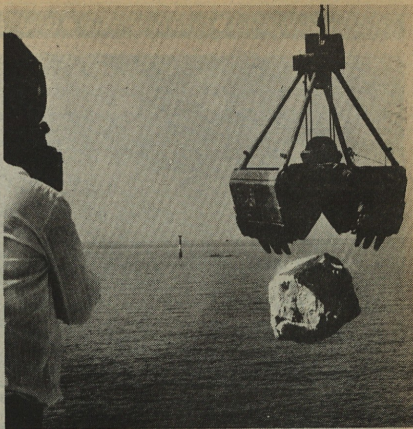
Prvi kadri filma so bili posneti v Umagu pri izgradnji lukobrana
