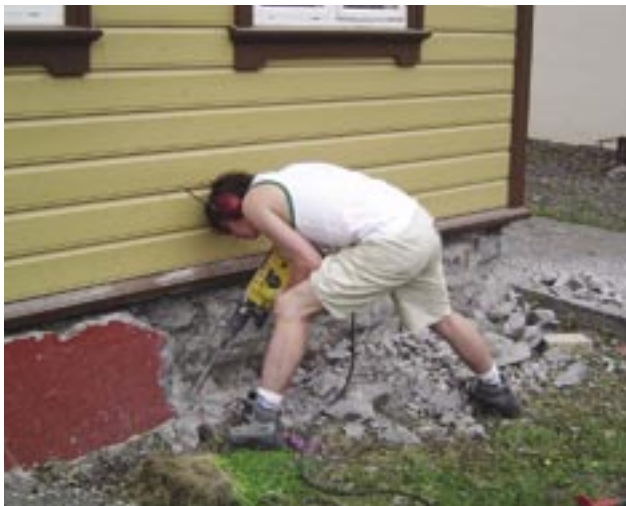
Slika 3: Najstarejša hiša v Siglufjörðurju je nekoč dobila novejši betonski omet. V času tabora naj bi ga odstranili in hiši vrnili njeno staro podobo. Delo je bilo fizično izredno naporno, zahtevalo pa je tudi nekaj spretnosti (foto: Barica Razpotnik).
