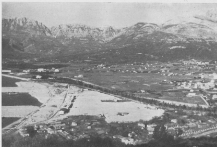
7. sl. Do maja 1961. leta izvršeni nasip Barskega Polja ob tovarni luki Fig. 7. To may 1961 performed artificial embankment of Barsko Polje near Port of Bar
