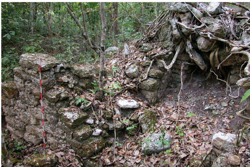
Figura 33. Uitzilná, Acrópolis Este, Estructura 27, elementos constructivos expuestos por los saqueadores; vista hacia el norte.
