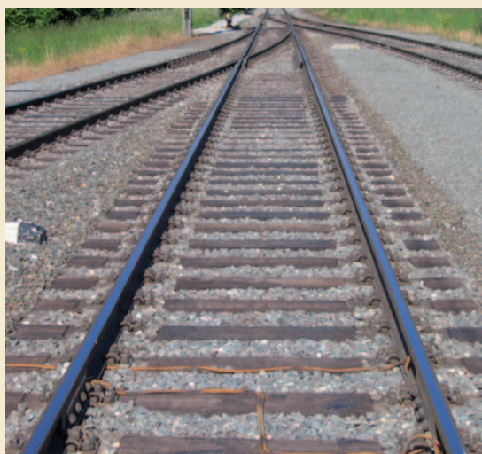
Kreozotno olje ima velik pomen v zaščiti železniških pragov (foto: M. Humar)
