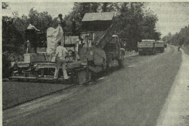
Moderna mehanizacija pri gradnji avtocest. Zadnji tip fini- šerja ABG za polaganje asfalta. Kapaciteta 300 ton na uro v debelini 30 cm. Finišer ima elektronsko nivelirno napravo Foto P. Strnad
