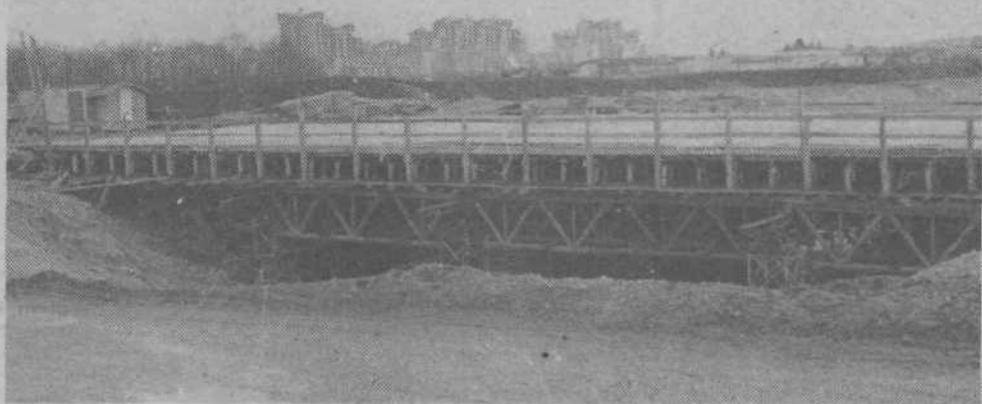
Nadvoz Saveljske ceste nad obvoznico je zabetoniran.
