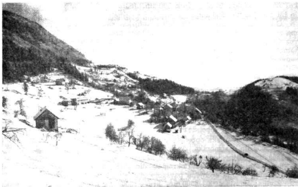
Po vojni obnovljene Dražgoše
